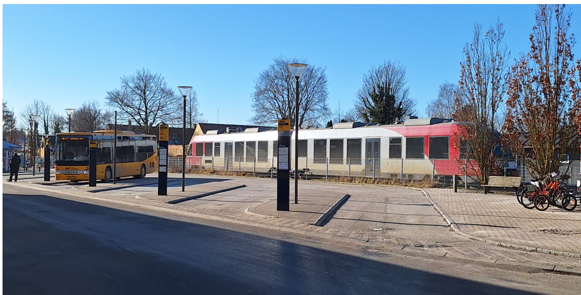
Billede 5: Store Heddinge station er sammen med Hårlev station knudepunkt for bus- og togdriften i Stevns Kommune
