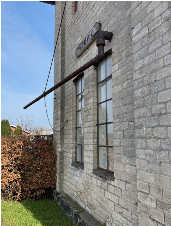
På remisen er røret, som blev anvendt til påfyldning af vand på damplokomotiverne, bevaret.
