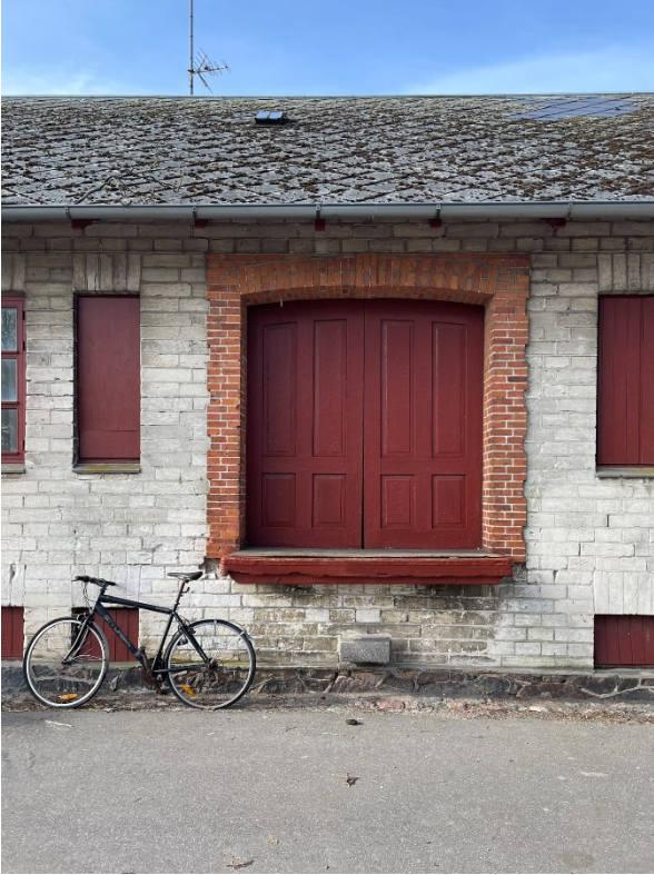
En af de bevarede læsseporte på varehuset. Læsseramperne er blevet sløjfet.
