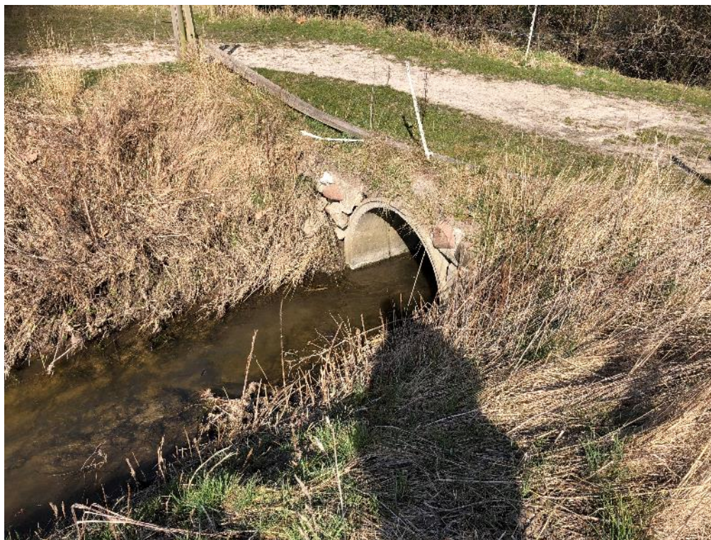
Figur 9: Udløb fra Ø150 cm røroverkørsel st. 5.198 m.
