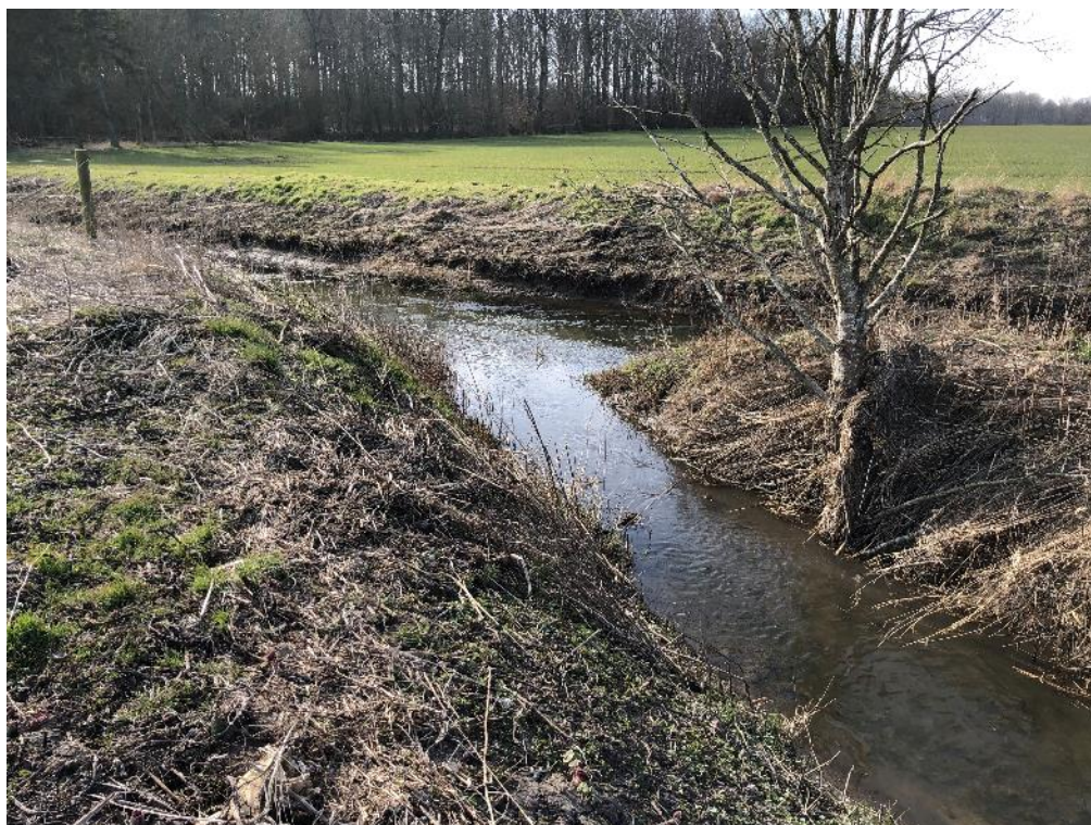
Figur 12: Udløb ved Tryggevælde Å st. 5.549 m.
