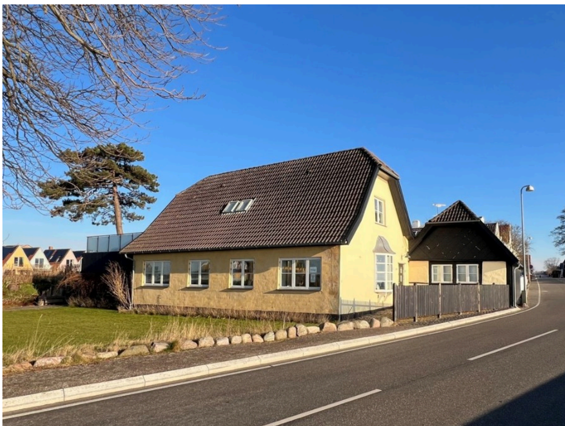
Fotoet viser den eksisterende bebyggelse på den sydlige del af lokalplanområdet. Området ses i retningen fra syd mod nord.
