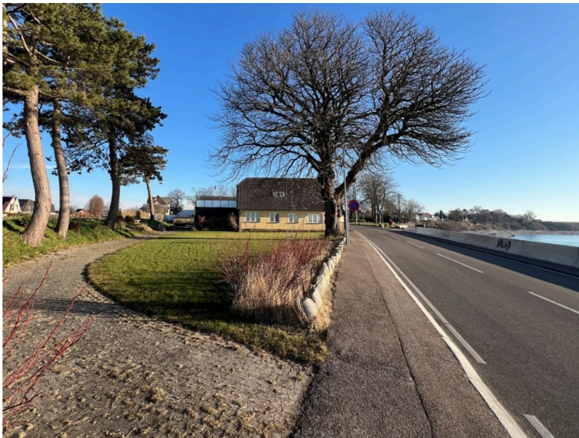
Fotoet viser den sydligste del af lokalplanområdet, som fremstår ubebygget. Området ses i retningen fra syd mod nord.
